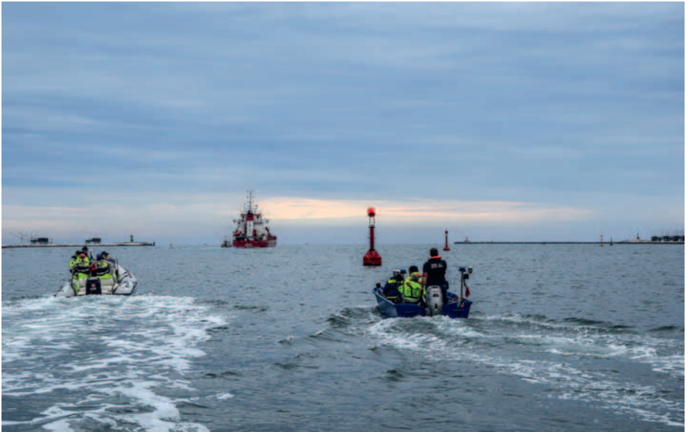
Die Boote, angeführt von der örtlichen Bootsgruppe, sind unterwegs in Richtung offenes Meer. Links und rechts sind die befestigten Dämme zu sehen, zwischen denen sich die Kästen der „MOSE“ befinden.
